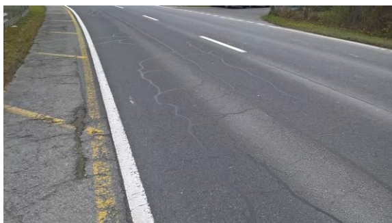
Abb. 5: Schadhafter Strassenbelag
