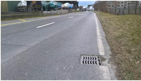
Abb. 6: Mangelhaftes Entwässerungssystem
