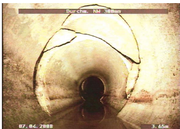
Abb. 10: Rohrwandung ausgebrochen
