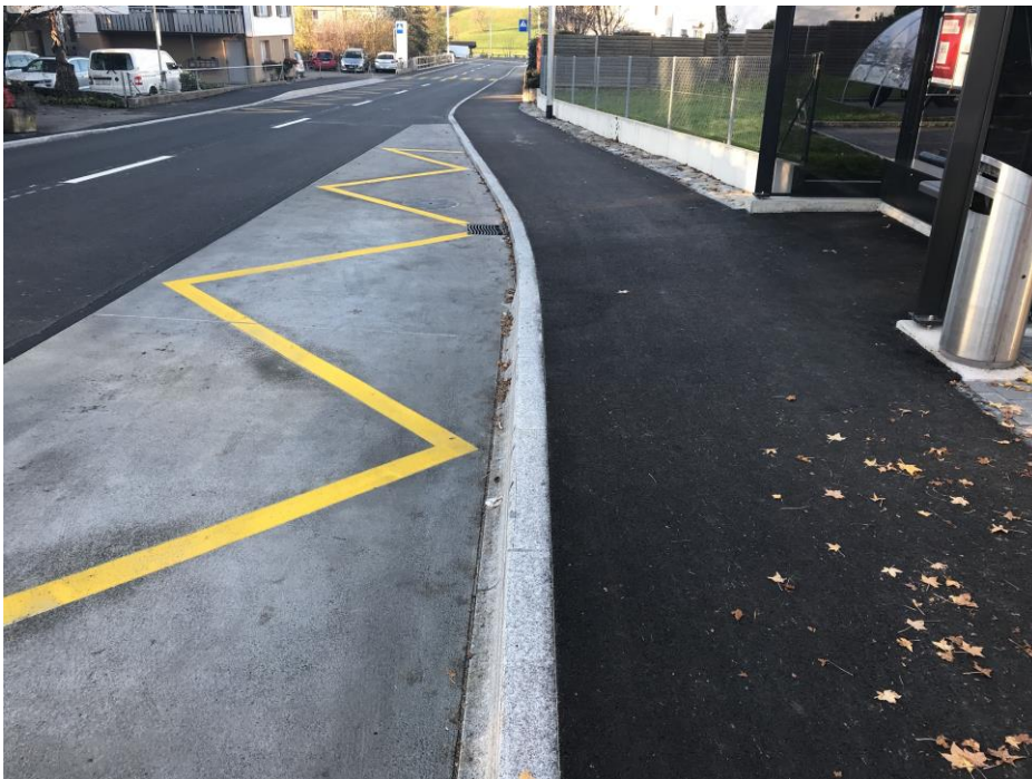
Die neuen Bushaltestellen Grüt der Dorfstrasse Allenwinden.
