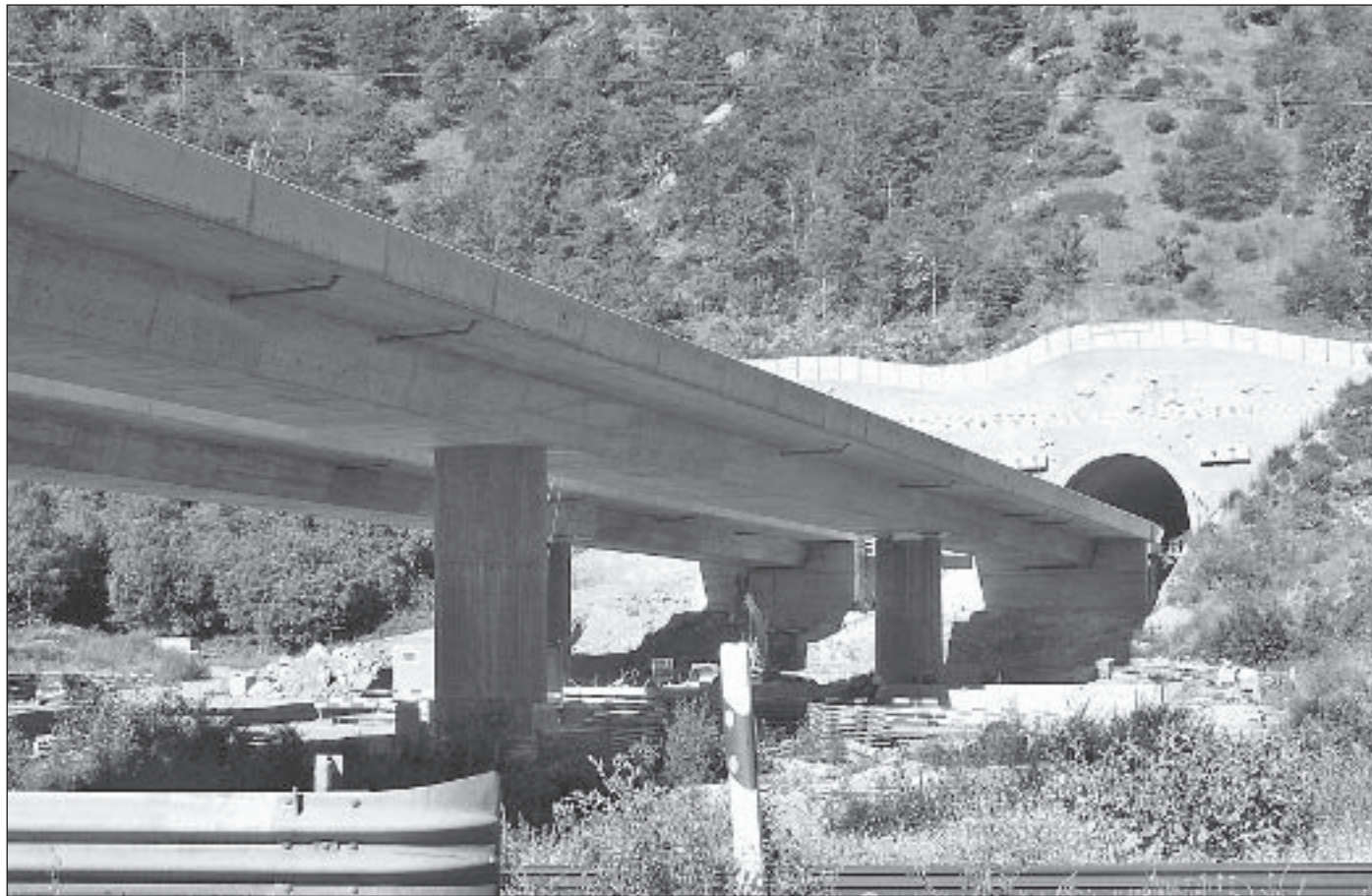
Wie und in welcher Form die Affäre um die unstatthaften Vorauszahlungen im Nationalstrassenbau weiter behandelt wird, hängt auch von der weiteren Entwicklung in einzelnen Dossiers ab. So werden zurzeit neben dem Einschnitt von Eholz auch die Brücken beim Staldbach der A9 näher vom Finanzinspektorat untersucht.
