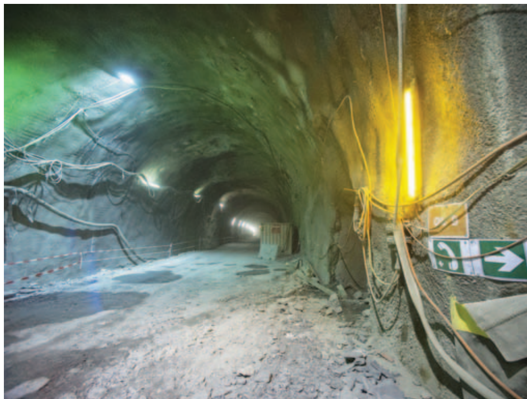
Le tube nord de l'autoroute au sud de Viège est encore brut de percement. La voûte devra être bétonnée avant que l'ouvrage puisse recevoir ses divers équipements. BITTEL
