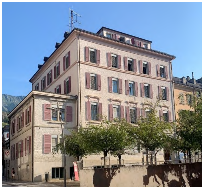
Bâtiment Rue de Lausanne 23
