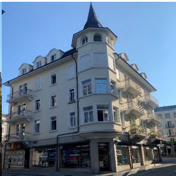
Bâtiment Rue des Remparts 6
