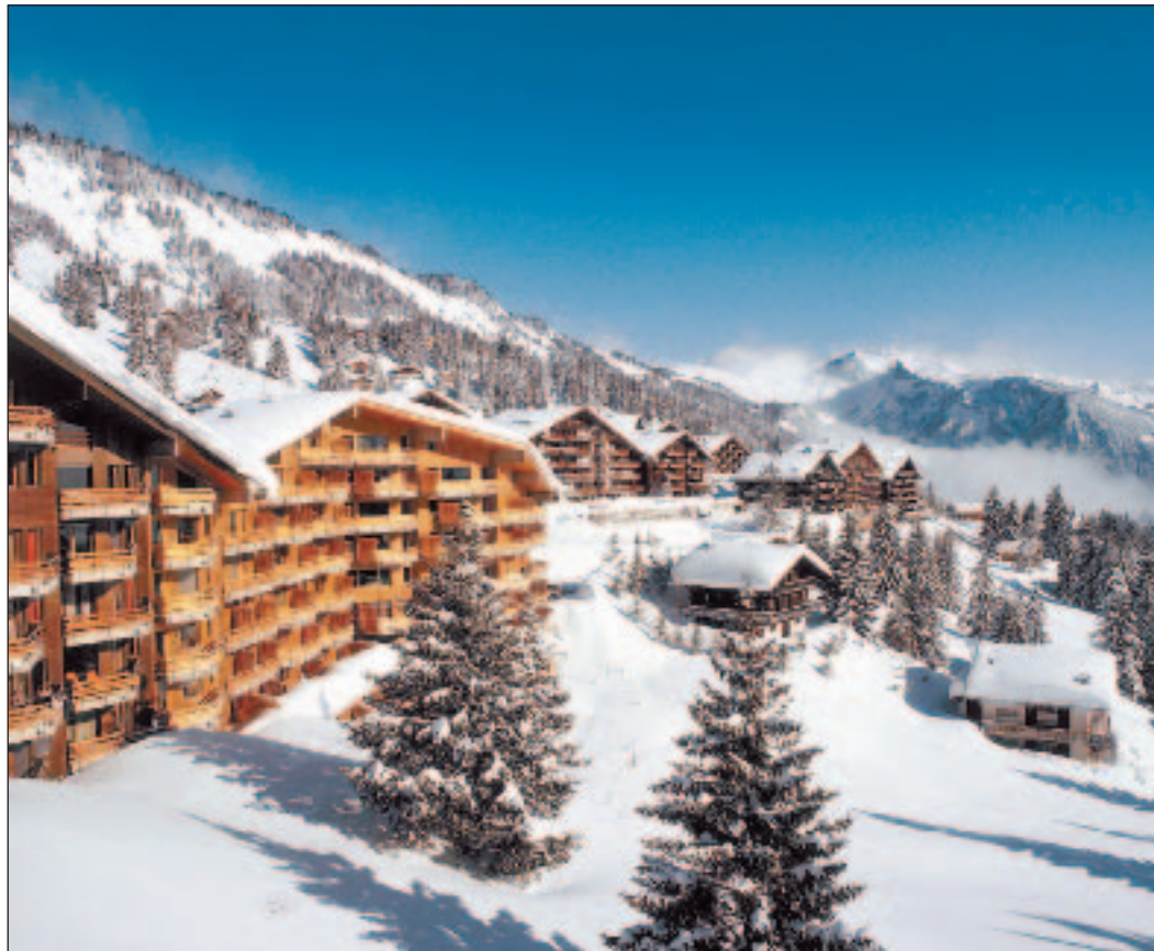
Die Mittelwalliser Skistation Anzère soll schon bald über eine grosse Holzheizungszentrale verfügen.
