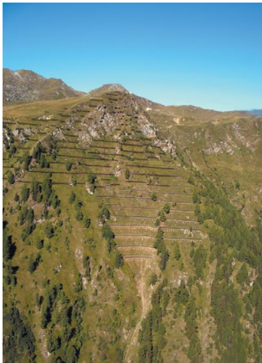
Lawinenverbauungen in Hérémence
