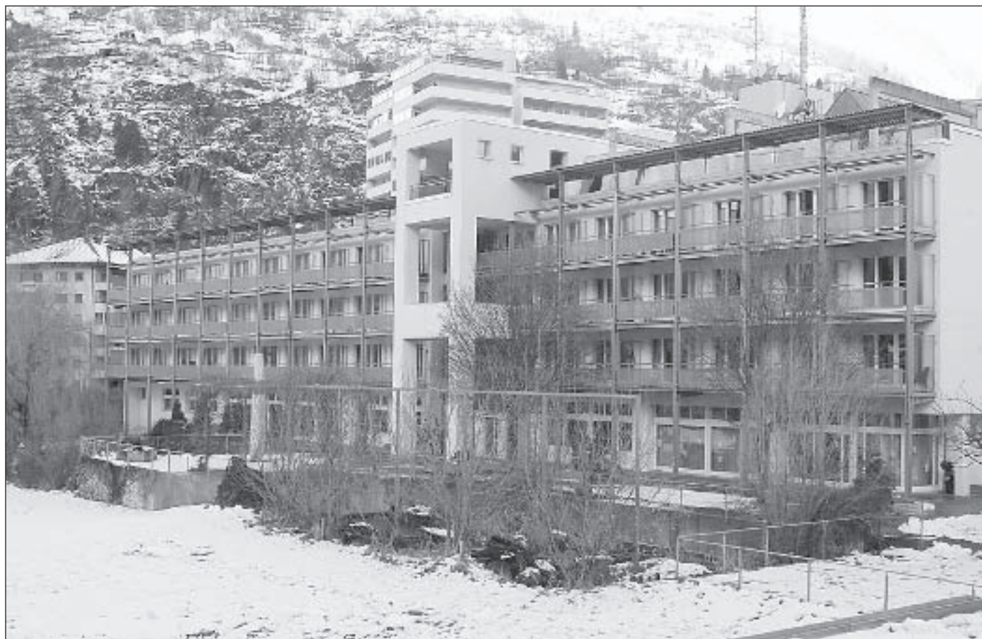
Das Alters- und Pflegeheim Englischgruss in Brig-Glis soll bis 2008 einen Anbau mit 45 zusätzlichen Betten erhalten.
