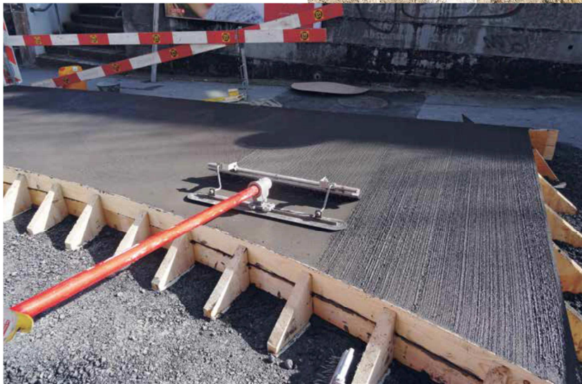
Fig. 23: Exemple de finition au balai
