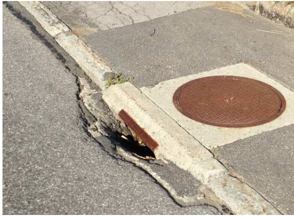
Fig. 3 : Récupération des eaux déficiente
