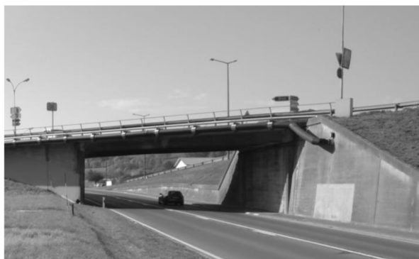
Photo 1 : Pont routier des Sorbiers sur la RC 601
