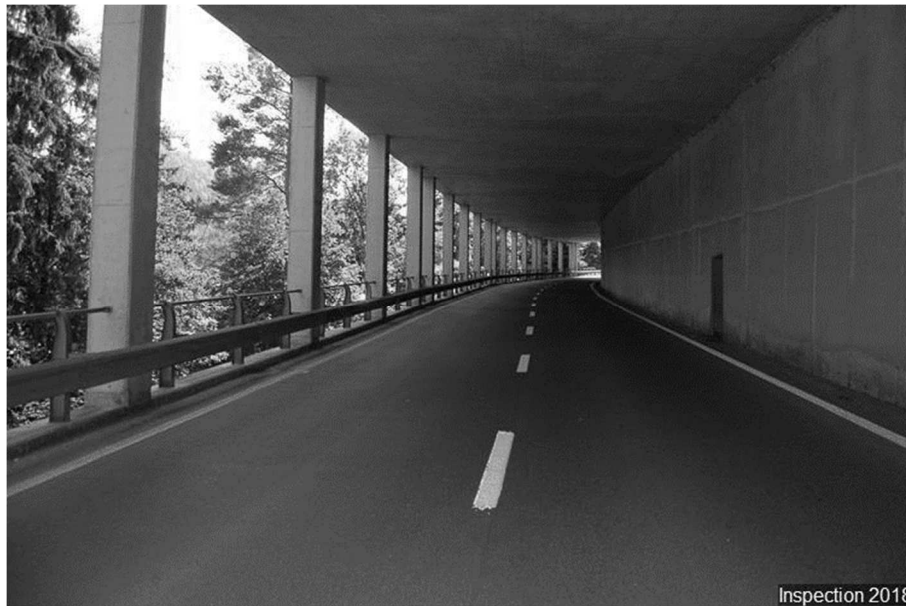
Vue générale de la galerie
