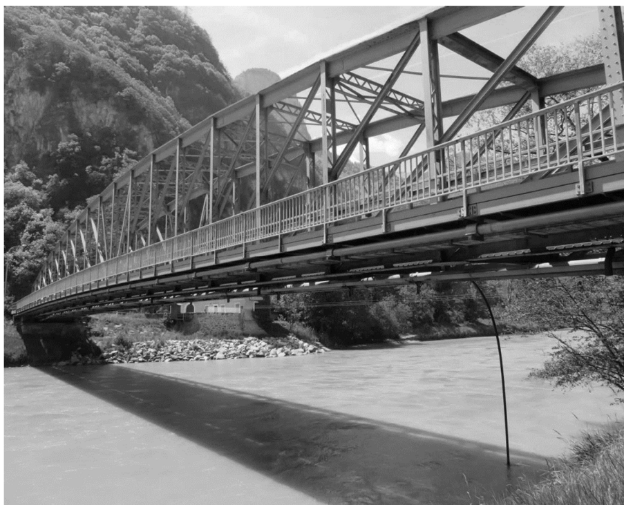
Vue générale depuis l'amont
