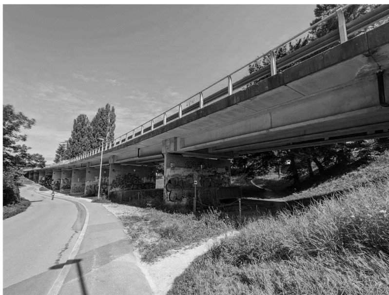
Vue générale latérale
