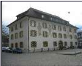
Zeughaus Lehnplatz 22 SID DS, AfBM (12AP)
