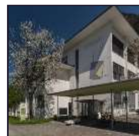
SUVA-Loftpark Dätwylerstr. 15 GSUD BB (10 AP)
