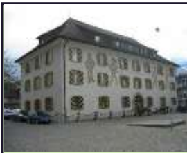
Zeughaus Lehnplatz 22 SID DS, AfBM (12AP)
