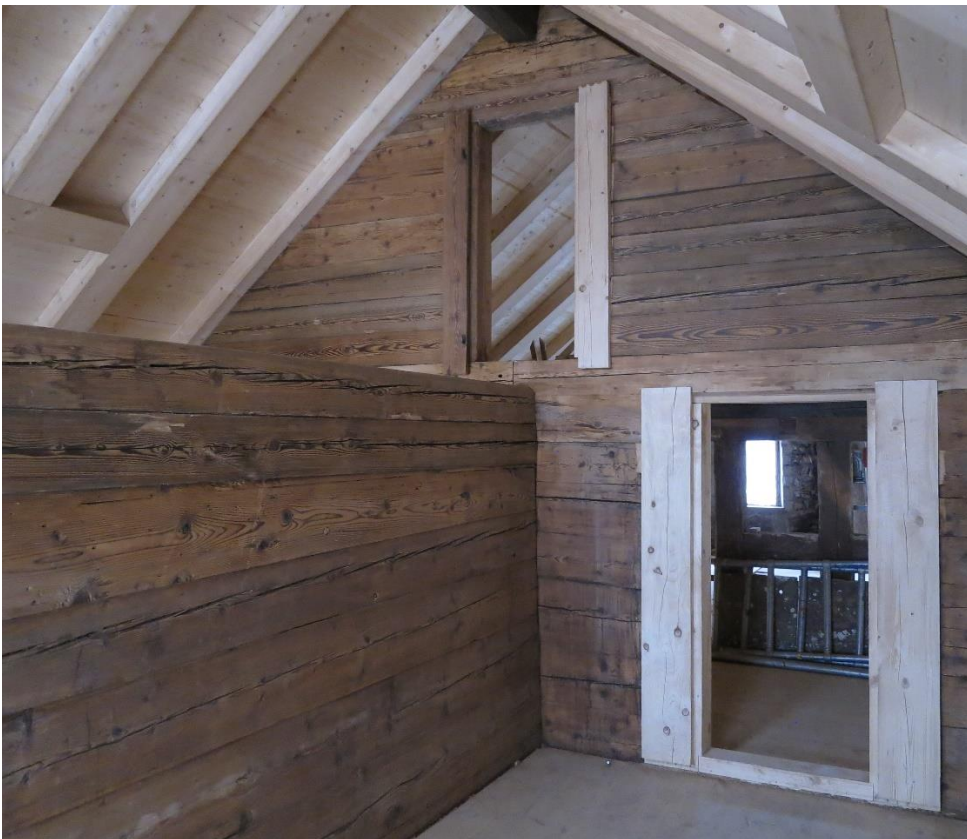
2) Innenansicht des Dachgeschosses
