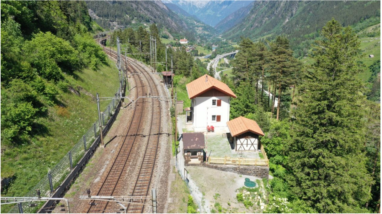
Das Bahnwärterhaus Eggwald bei Wassen wurde neu restauriert und stellt nun ein wichtiges Kulturdenkmal dar. (Foto Denkmalpflege SBB).
