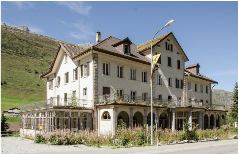
Das ehemalige Hotel Meyerhof in Hospental wird nun saniert. Die Baustelle kann im Rahmen der Denkmaltage besichtigt werden (Foto HTS Architekten + Partner AG).
