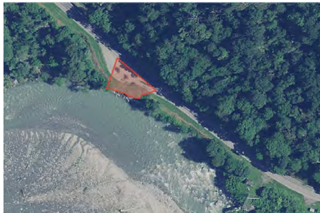
immagine dopo l'evento alluvionale
