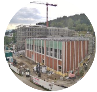
Neubau Kantonsschule Ausserschwyz
