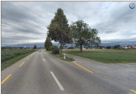
Beispiel Luzernstrasse in Subingen (Übergang ohne Trennelement).
