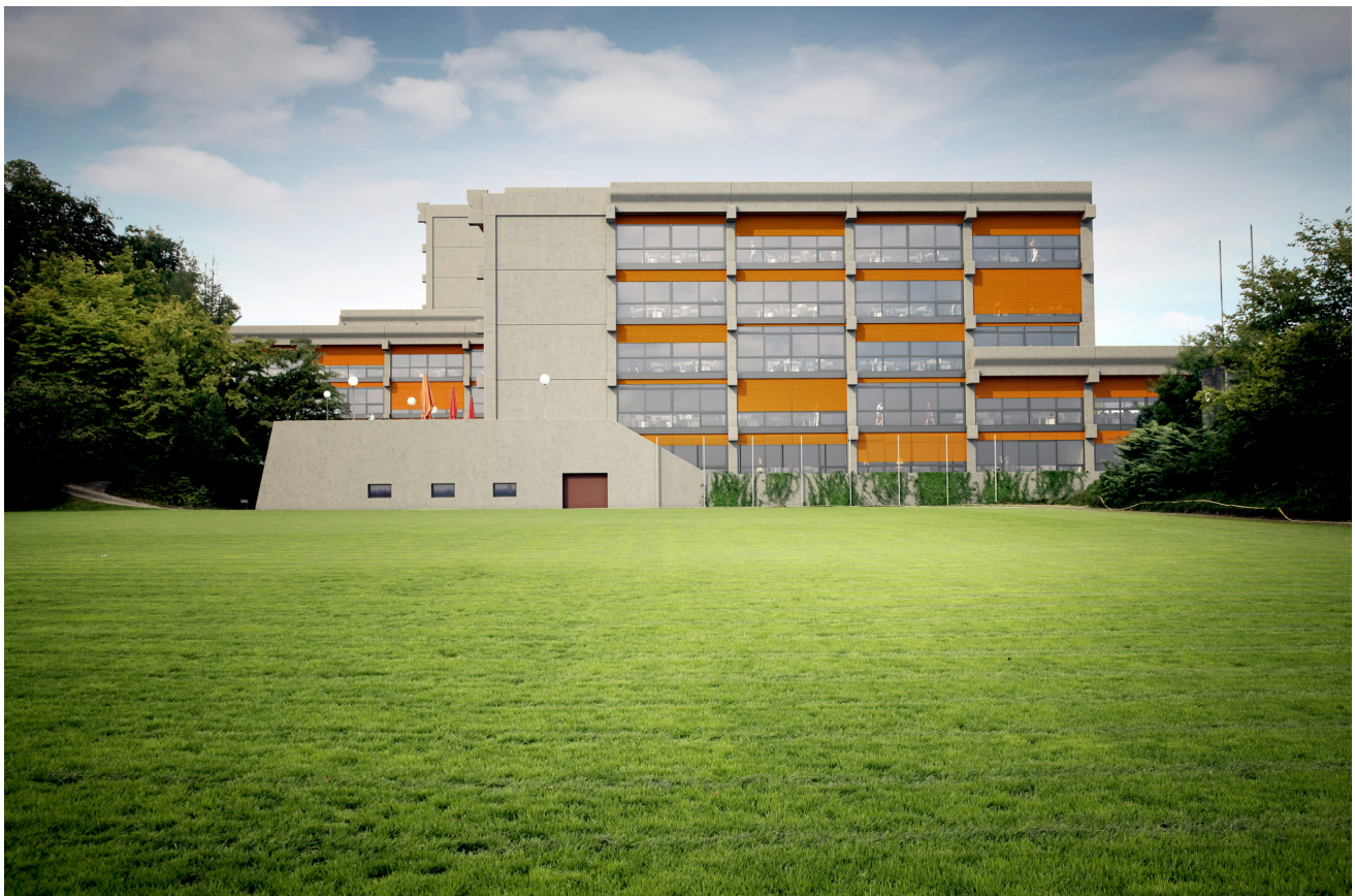
Visualisierung - S  dwestansicht - nach der Sanierung
