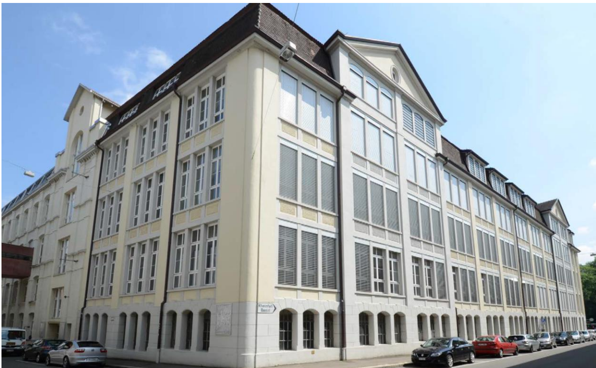
Abbildung 11: Kammgarn Westflügel Ecke Baumgarten- Klosterstrasse (Quelle: Baugeschichtliches Detailinventar Vestigia)
