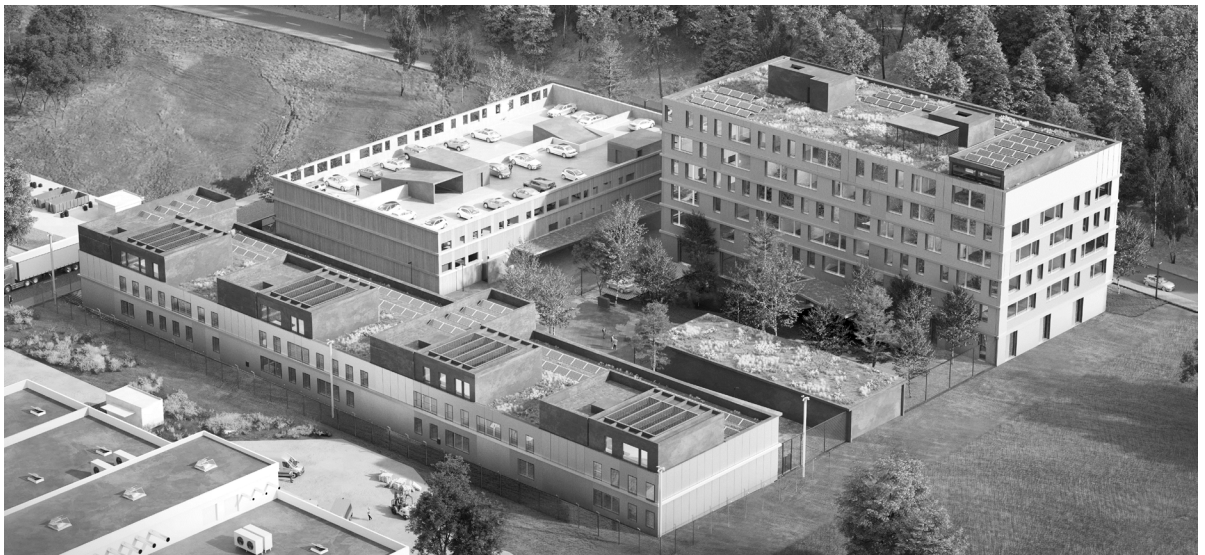
Visualisierung des aktuellen Bauprojekts des Polizei- und Sicherheitszentrums
