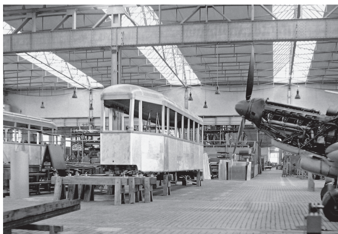
Montage der Anhängewagen der Serie C4 1401-1415 der Basler Verkehrs-Betriebe (BV), bestellt als C4 751 - 765, in der Dornier-Werke Altenrhein AG in Thal, 1947. (Bild: Werkaufnahmen Dornier)
