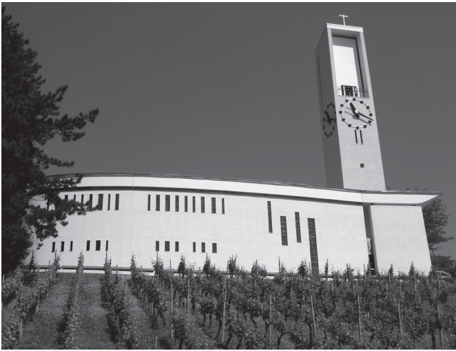
Katholische Kirche in Rebstein. (Bild: zVg Kantonale Denkmalpflege)
