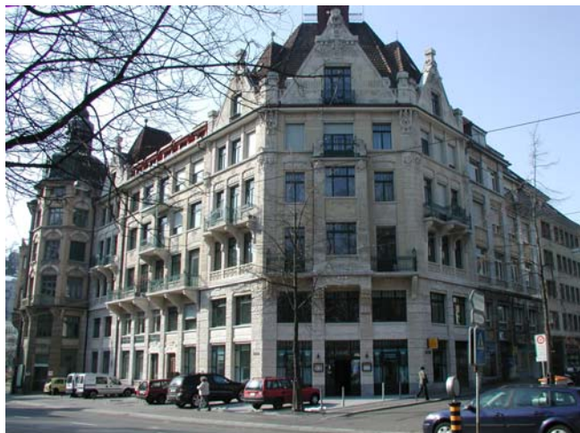
Fassadensanierung Wohnhaus Burggraben 22/24, St.Gallen (Foto: Kantonale Denkmalpflege)
