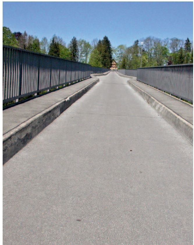
Haggenbrücke St.Gallen/Stein AR einst und heute (Bild: Kantonale Denkmalpflege)
