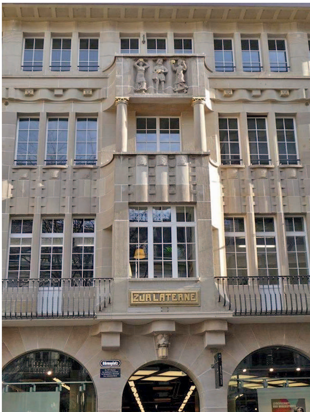
Multergasse 1 bis 3, St.Gallen (Bild: Kantonale Denkmal- pflege)
