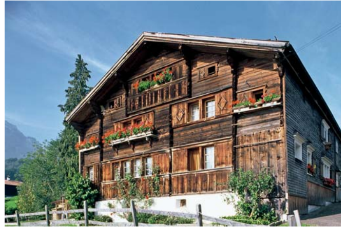
Grabs, Bauernhaus im Lehn. Das an prominenter Lage errichtete Strickgebäude aus dem Revolutionsjahr 1789 gilt wohl zu Recht als eines der schönsten Häuser am Grabserberg.
