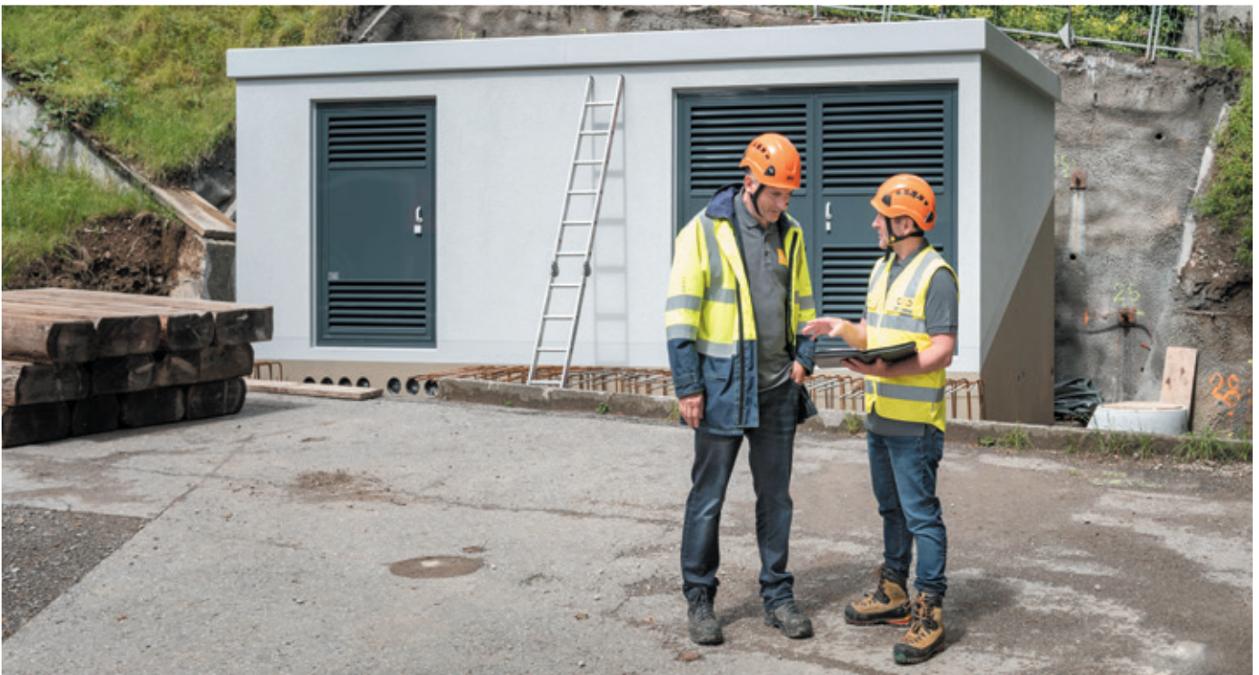
Die alte Transformatorenstation in Kirchhofen, Sarnen, war sanierungsbedürftig. Zur Sicherstellung der erweiterten Versorgung für Hofmatt, Kirchhofen, Stalden und Ramersberg plante Stefan Bucher (rechts) die moderne Anlage. Die Platzsuche und die Gestaltung erfolgte in Abstimmung mit dem Heimatschutz. Für Bau und Inbetriebnahme der 40 Tonnen schweren Anlage war Ivo Koch (links) vom Netzplanungsteam verantwortlich.
