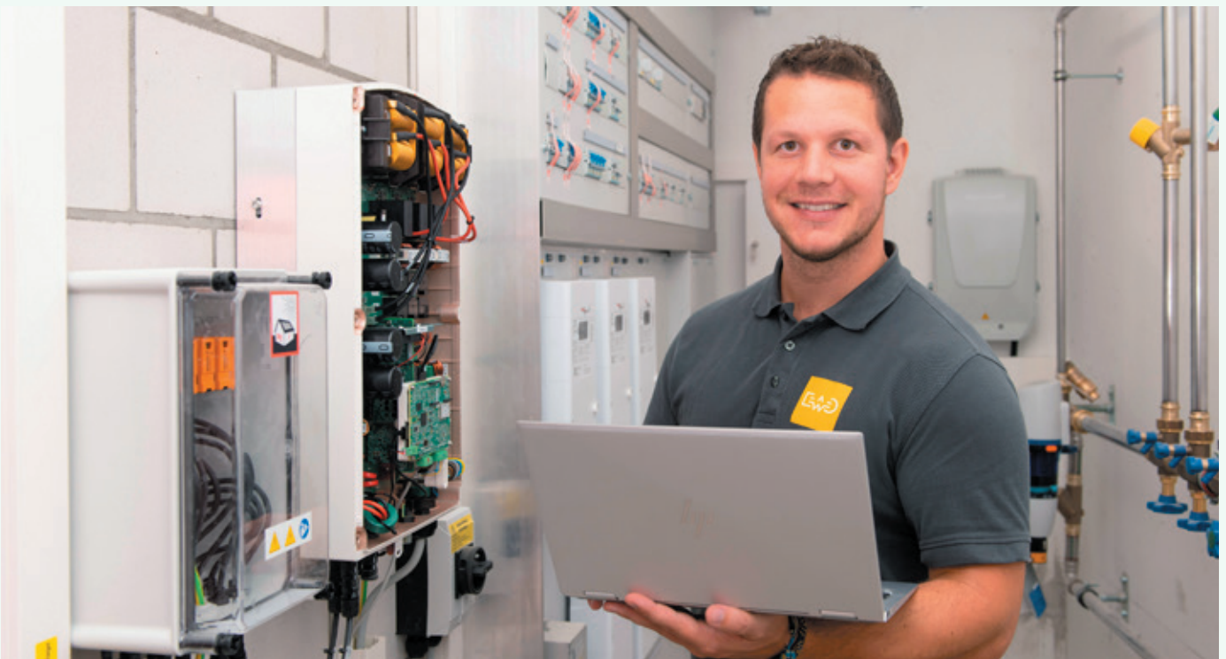
Für die Mehrfamilienhäuser Gumeli in Alpnach installierte das Team des Elektrizitätswerks Obwalden sämtliche Elektroinstallationen sowie die Photovoltaikanlagen auf den sieben Dächern der Überbauung. Der Projektleiter Photovoltaikanlagen, Silvan Eller, kontrolliert die Systeme ein letztes Mal und setzt den Wechselrichter in Betrieb. Ab diesem Zeitpunkt werden die Wohnungen sowie die technische Infrastruktur bei Sonnenschein mit eigener Solarenergie versorgt.
