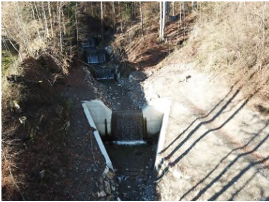
Abbildung 10: Fixpunkt 3 mit Sperre 24.1 (Quelle: Trigonet AG).
