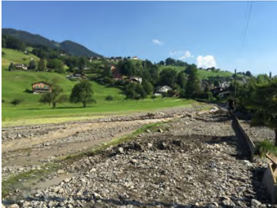
Abbildung 1: Geschiebeablagerungen im Deltabereich des Blattibachs. Durch die Intervention während dem Ereignis wurde zum Schutz des Siedlungsgebiets in der Goldmatt die rechtsseitige Entlastung provoziert.
