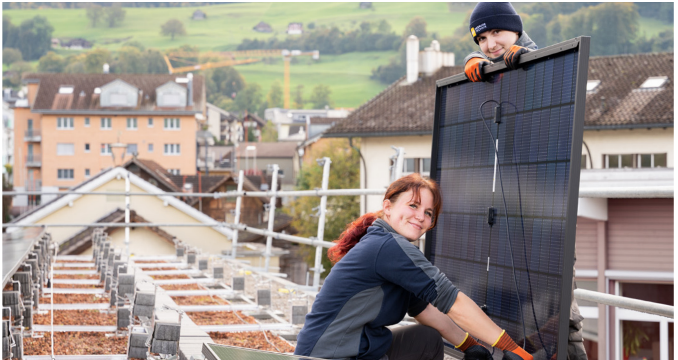
Beim Schulhaus Willa in Kerns montierten Ilona Bütler (links), Monteurin Photovoltaik, zusammen mit dem Lernenden Solar- monteur, Joe Carney (rechts), Panels für die neue Photovoltaikanlage. Die Montage auf dem begrünten Flachdach erfolgte in Ost-West-Ausrichtung zur optimalen Nutzung der Sonneneinstrahlung. Die gesamte Anlage wurde erhöht montiert, damit die Begrünung ausreichend Freiraum erhält, sodass die Panels nicht durch die Begrünung beschädigt werden und der Unter- halt gewährleistet ist.
