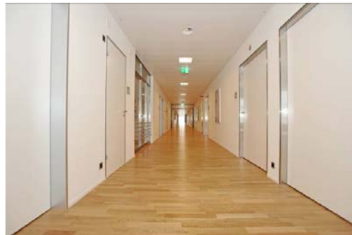
Stationsflur während und nach der Optimierung
