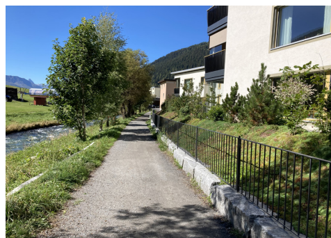
Erhöhte Bauweise als Schutz vor Überschwemmungen.
