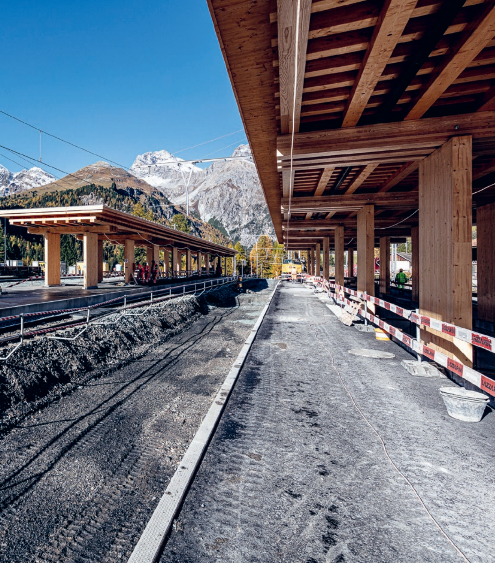
Erneuerung Bahnhof Preda
