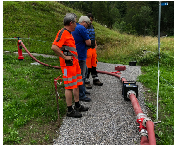
Abnahme neuer Hydrantenleitungen im Krauch, Glarus Süd
