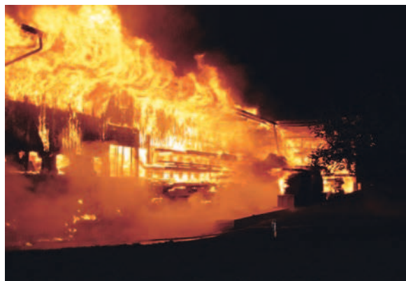
Brandfall mit Totalschaden einer Holzbaufirma im Sernftal.
