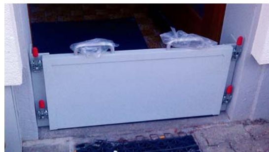
Temporäre Objektschutzmassnahme gegen Hochwasser
