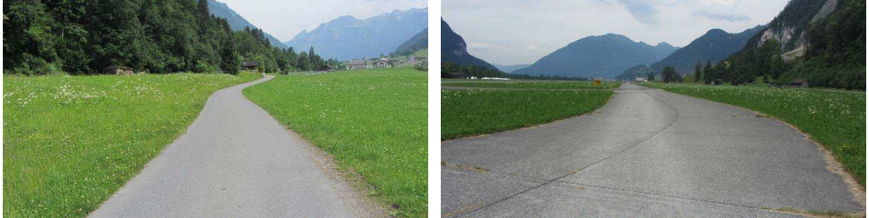
Abbildung 16: Asphaltierter Weg (links) und Betonplatten im Bereich des Flugplatzes (rechts)
