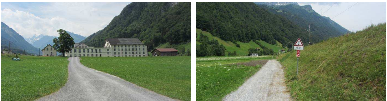
Abbildung 17: mit Oberfläche Schotter / Kies gut befahrbarer (links) und schlecht befahrbarer Weg (rechts)
