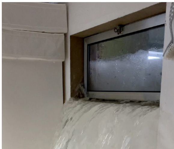
Eindringen von Hochwasser in einen Kellerraum
