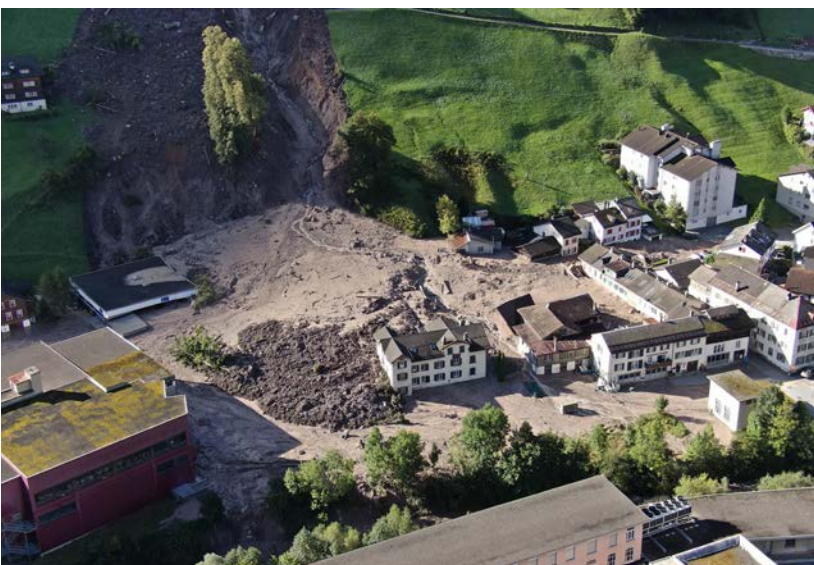
Hangrutsch der Wagenrunse mit grossen Gebäudeschäden
