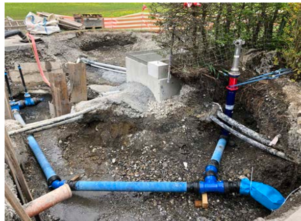
Beiträge unterstützten massgeblich die Sicherung und Verbesserung der Löschwasserversorgung
