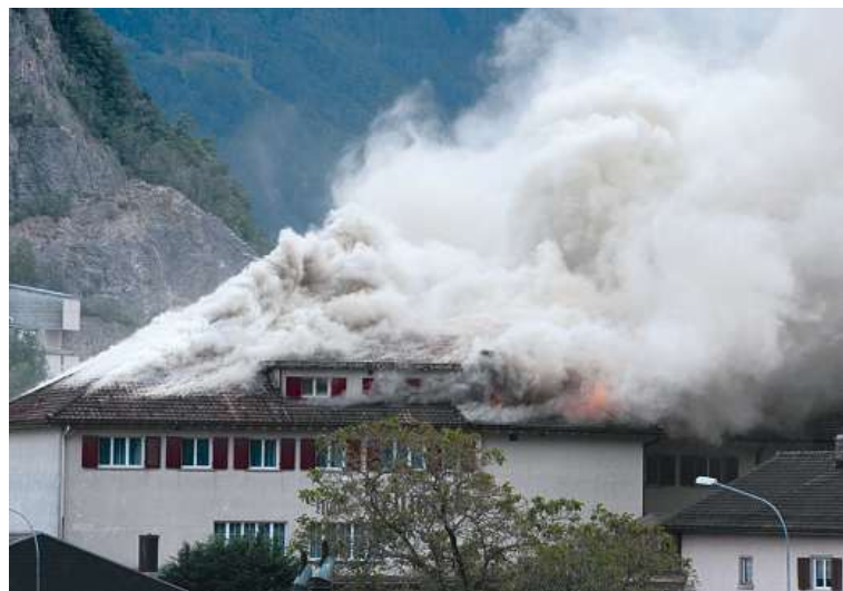
Dachstockbrand in Netstal mit hohem Sachschaden
