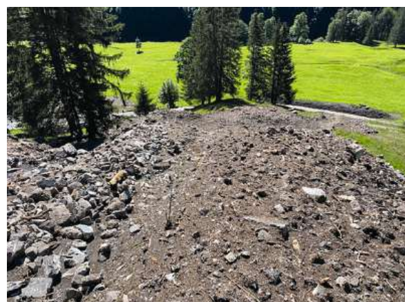
Überführte Runse im Klöntal
