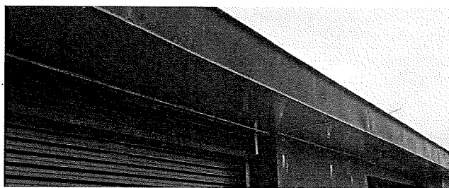
Photo : sous-faces de toit en cuivre – attique bâtiment C
