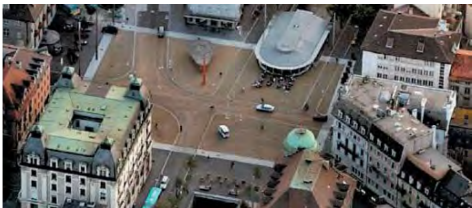
Fig. 9 Ville de Bienne, Place Centrale Transformée en 2002 en zone de rencontre. La régulation et la réglementation du trafic fonctionnent grâce à une conception sobre et judicieuse qui revalorise l'espace public.
