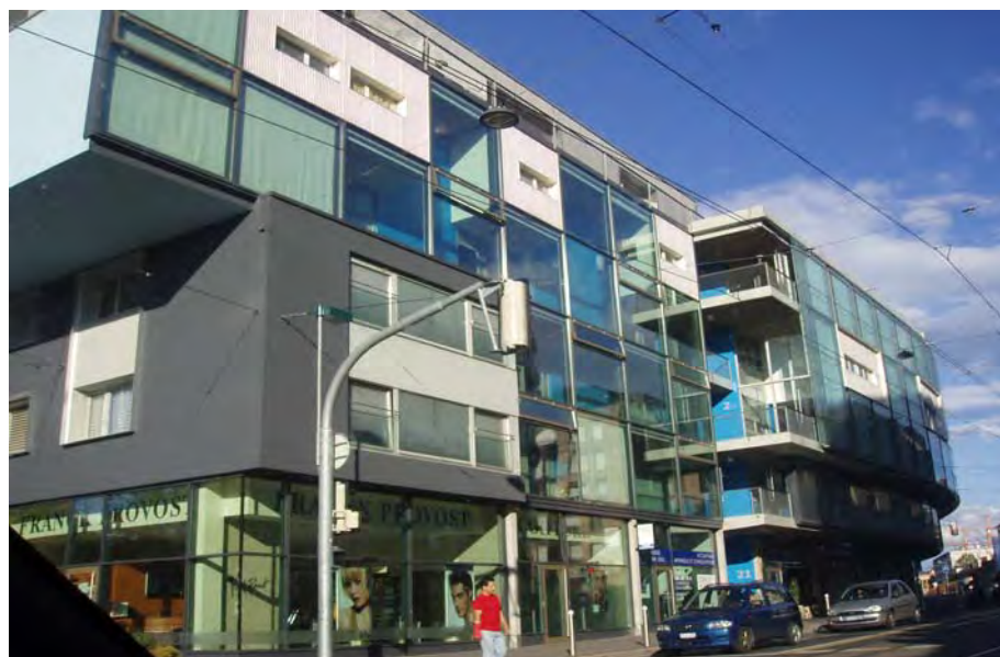
Fig. 50 Immeuble sur Rue de Genève avec dispositif de protection phonique partielle sur façade.
