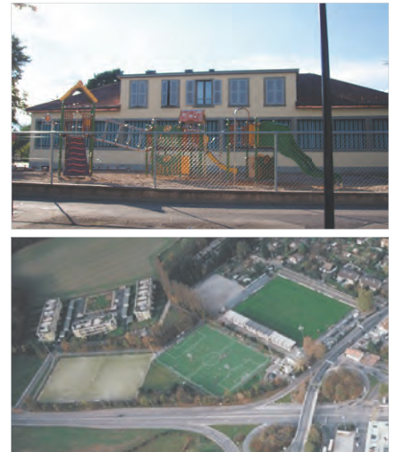
Fig.10 En haut, Ecole du Plateau En bas, Centre sportif de Sous-Moulin, vues partielles.
