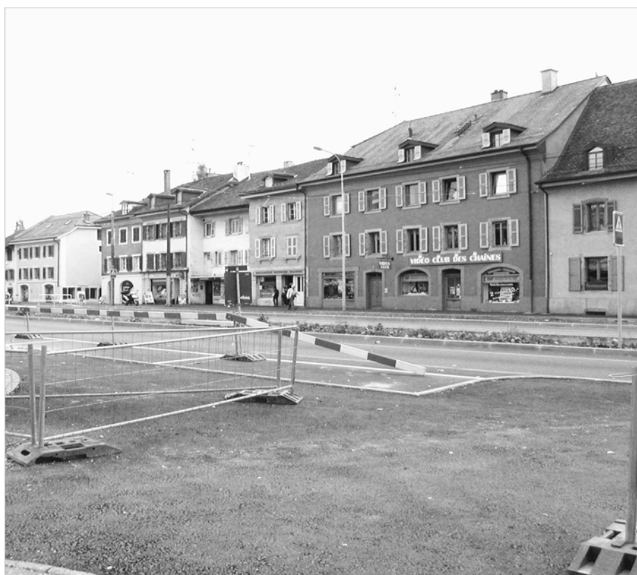
Fig. 1 Front sud de la rue de Genève. Secteur classé en zone 4B protégée, avec constructions contigües datant de la période sarde
