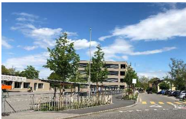
Complexe scolaire et communal du Grand Salève
