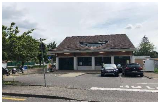
Poste de Vessy
