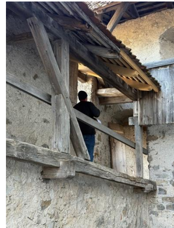
Abb. 4 Wehrgang – Notreparatur am Dachstuhl
