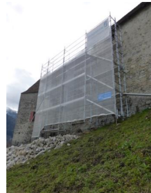
Abb. 1 Nördlicher Teil der Mauer – Umfang der Reparaturarbeiten
