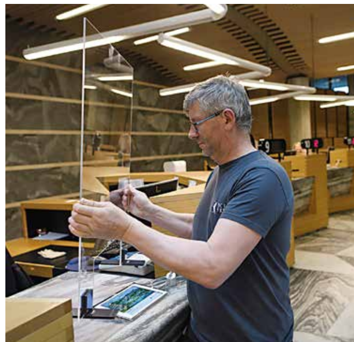
Installation plexiglas de protection
