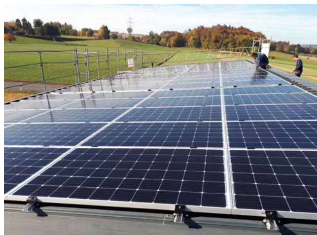
Centre collecteur de Guin – installation des panneaux solaires Sammelstelle Düdingen – Montierung der Solarzellenpanels
