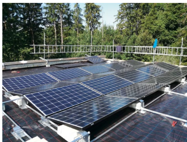
Centre collecteur de La Joux – installation des panneaux solaires Sammelstelle La Joux – Montierung der Solarzellenpanels
