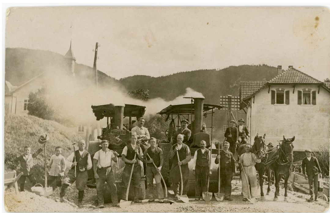
Mémoires d'Ici, Bestand der Gemeinde Sonceboz-Sombeval (Collection René Rimaz) Strassenwalzarbeiten in der Rue du Collège in Sonceboz, 1923
