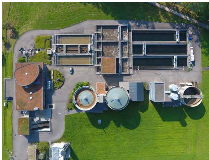
Abwasserreinigungsanlage Bild: ARA Region Interlaken
