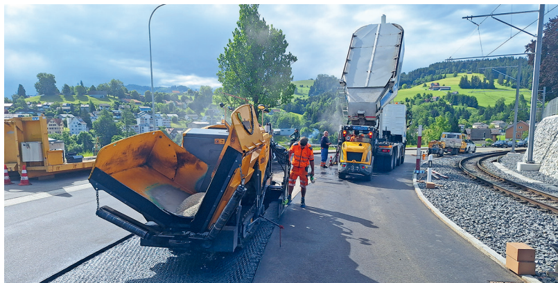
Bild 9 Speicher Fussgängerübergang Bendlehn
