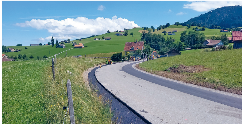
Bild 8 Hundwil Örtlismühle - Ramsten, Gesamterneuerung
