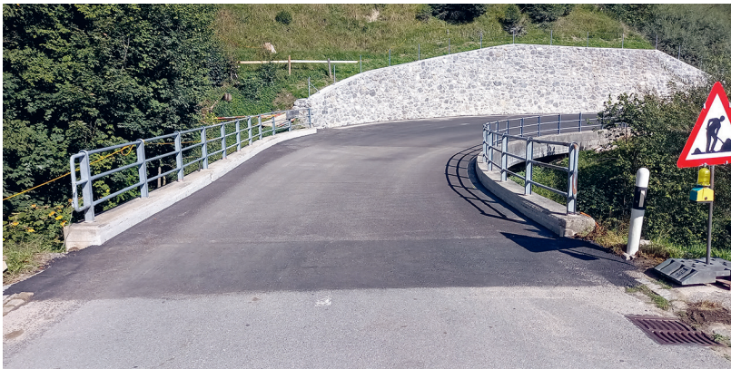
Bild 5 Urnäsch, Erneuerung Schönaustrasse
