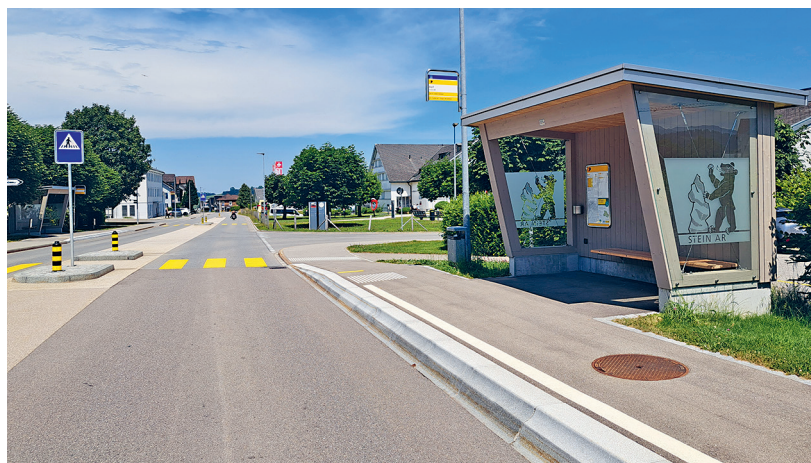
Bild 4 Behindertengerechte Bushaltestelle beim Gemeindehaus in Stein, Umbau 2023 in enger Zusammen- arbeit zwischen Tiefbauamt und Gemeinde.
