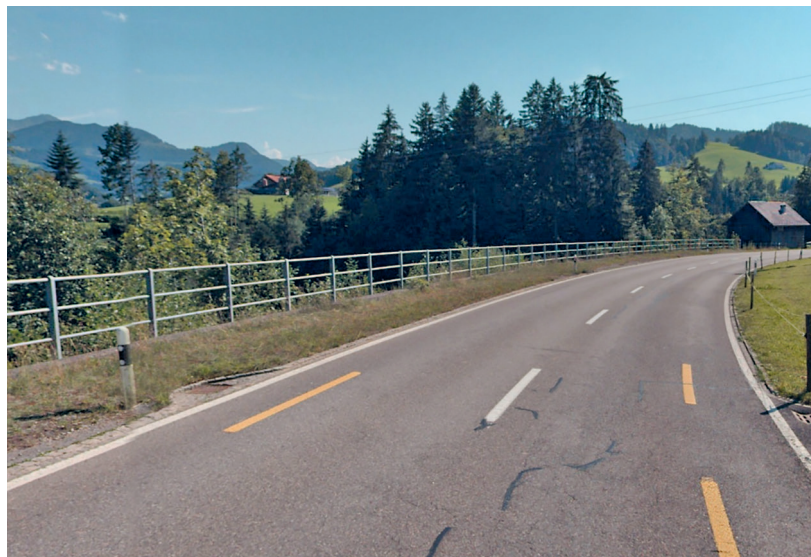
Bild 11 Kantonsstrasse Nr. 8, Waldstatt- Urnäsch, Blickrichtung Urnäsch vor dem Murbachrank, Ende der markierten Radstreifen infolge zu schmaler Strasse.
