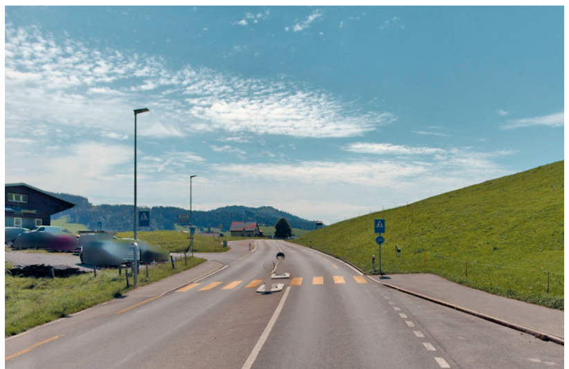
Bild 14 Kantonsstrasse Nr. 7, Waldstatt - Schönengrund, Blickrichtung Brisig. Beim Einlenker Winkfeld wechselt das Trottoir für rund 500 m die Seite. Für eine durchgehende Veloverbindung Waldstatt - Schö- nengrund - Neckertal soll der Querschnitt auf diesen 500 m umgebaut werden. Die Strecke hat ohnehin Sanierungsbedarf beim Einlenker Winkfeld
