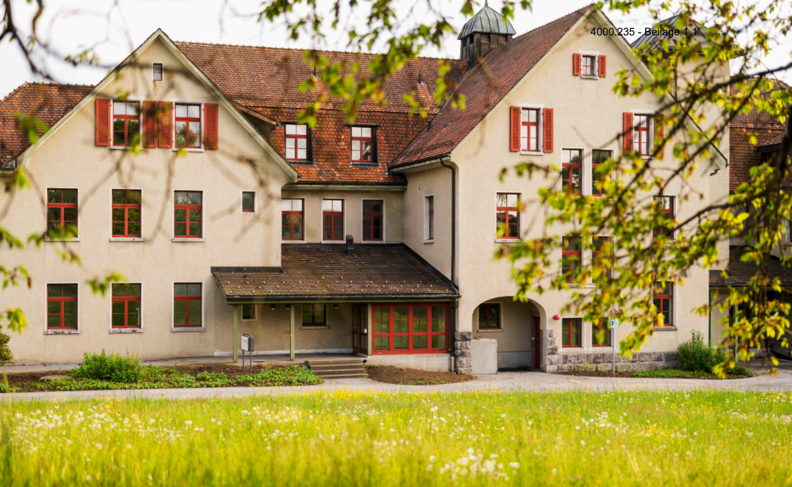
Haus 3 vor der Renovation.
