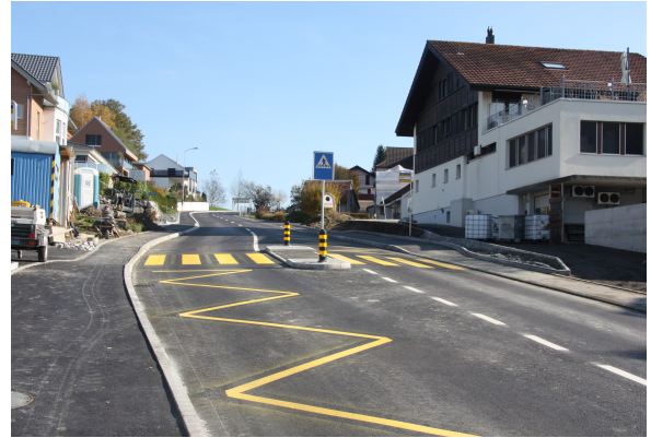
Bild 7: Sanierter Fussgängerübergang an der Kantonsstrasse Nr. 34 in Lutzenberg Brenden, inkl. Bushaltestelle mit Haltekante nach BehiG
