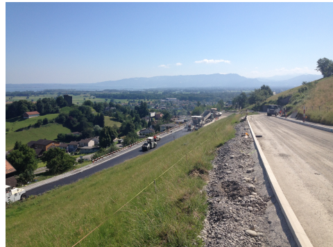
Bild 13: Schneggentöbeli-Brenden, Lutzenberg: Erneuerung
