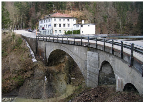
Bild 15: Zweibrücken, vorne die Goldachbrücke und hinten in der Kurve die Holderenbachbrücke. Letztere stammt aus dem Jahre 1848 und muss dringend ersetzt werden.
