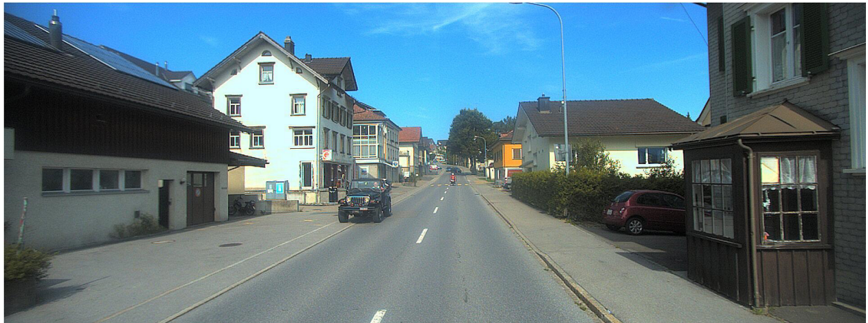
Bild 20: Längerfristiger Bedarf auf der Kantonsstrasse Nr. 13, Ortsdurchfahrt Gais; knappe Strassenbreiten und fehlender Raum für den Langsamverkehr.
