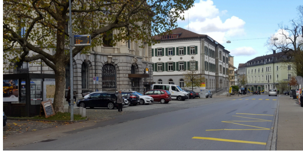
Bild 5: beidseitig stark frequentierte Bushaltestelle vor der Post in Herisau, heute ohne behindertengerechte Haltekante, Konflikt mit Parkplätzen absehbar.
